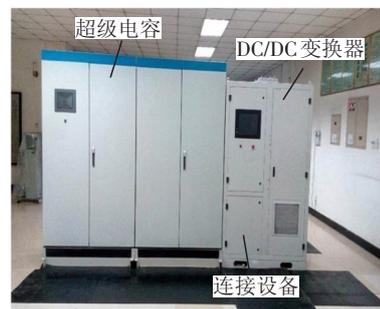
图 8 超级电容储能装置安装于牵引变电所
